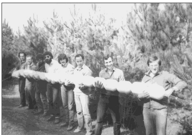
Pose des flotteurs sur les câbles électriques - 1983
