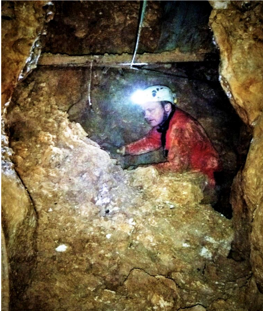
Vue sur l'effondrement au bout du Tunnel
